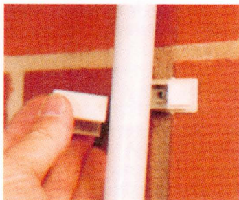
A védőcsöveket tartóbillincsekkel rögzítjük a falhoz
