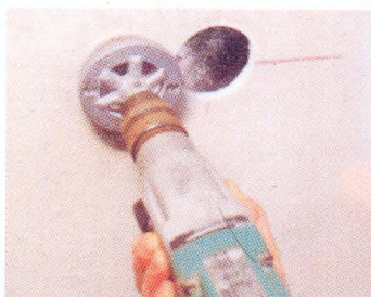
Lyukfűrészszel méretre kifűrészeltjük a két furatot
