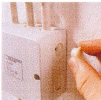
Kábelösszekötő dobozok rugalmas tömítőmembrános kábelvezetéssel
