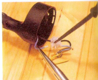
A lámpatestekben lévő vezetéket csak sorozatcsatlakozóval szabad a hálózatra kötni
