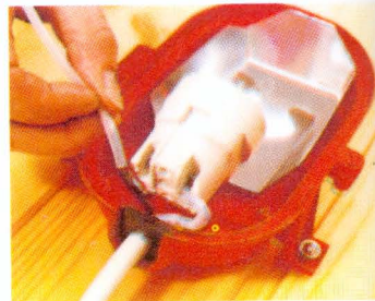
A lámpatestbe csatlakozó kábelt védeni kell a keletkező hővédelemet ad az, ha az egyes vezetékágakra szilikoncsövet húzunk
