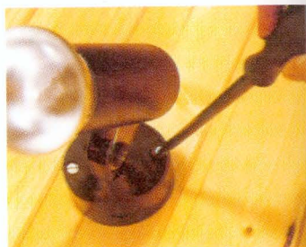
A fénysugárázó facsavarokkal rögzítjük. A lámpatest talpa eltakarja a sorozatcsatlakozót és a csatlakozóvezetékvégeket
