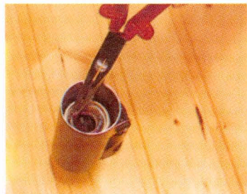
Az izzólámpa menetes végét hosszúcsőrű fogóval megfogjuk, és kicsavarjuk a foglalatból
