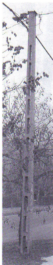
4.6.6. ábra. „B” _ típusú tartóoszlop
