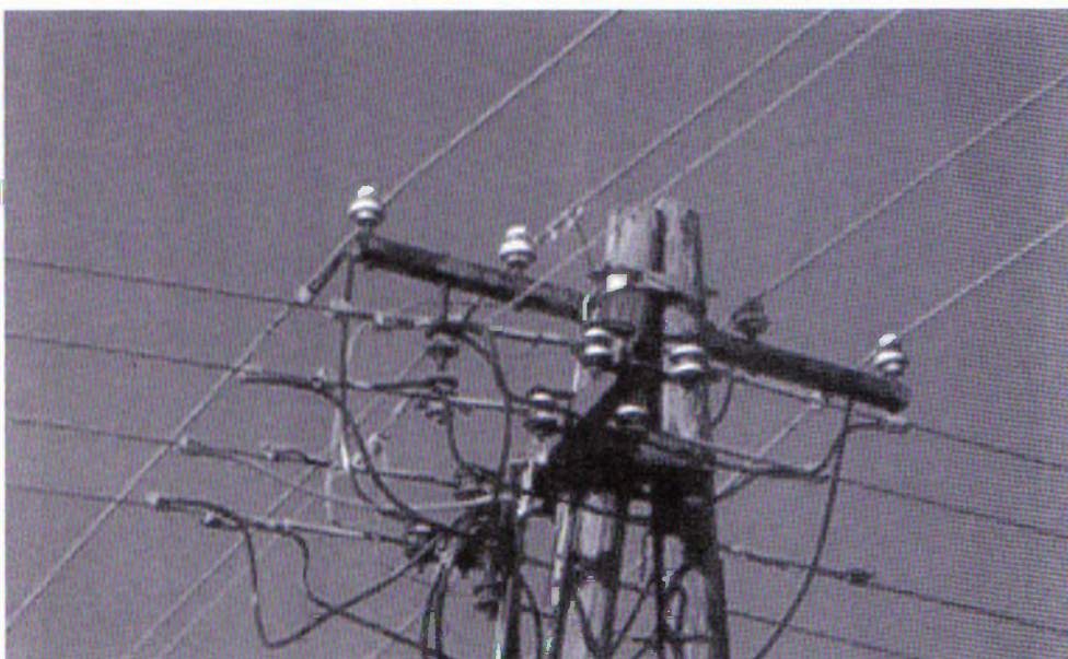
4.6.1. ábra. Leágazó oszlopfej szerkezet, faoszlopon
