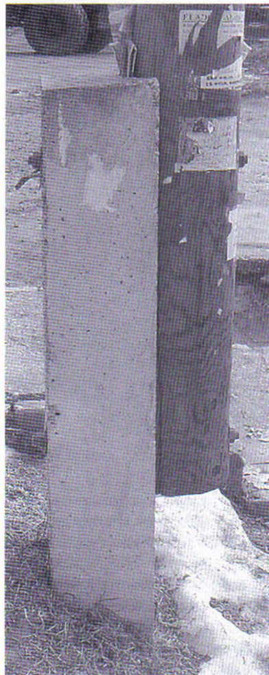
4.6.2. ábra. Fa tartóoszlop betongyámmra szerelve
