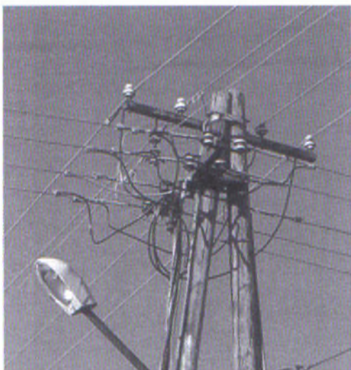
4.4.2. ábra. Síkelrendezésű hálózat kialakítása és oszlopfej elrendezése, keresztleágazással
