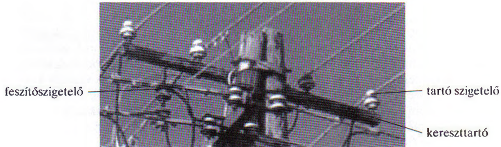
4.5.2. ábra. Kereszttartóvas, tartószigetelők és feszítőszigetelők „A” oszlopfejen
