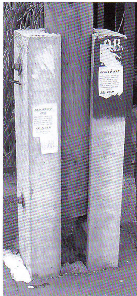
4.6.3. ábra. Fa, tartóoszlop kettős betongyámon
