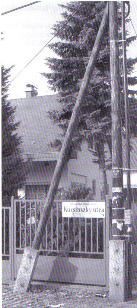
4.6.4. ábra. Kitámasztott faoszlop
