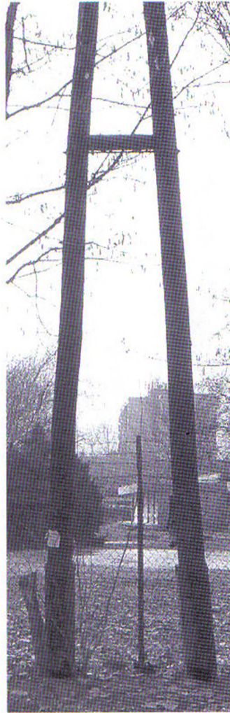
4.6.5. ábra. „A” oszlop felső kötőfával
